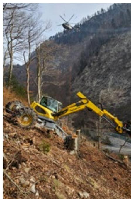
**Baumeisterarbeiten – Der Rückbau in dem sehr steilen Gelände erfolgte mittels Schreitbagger und dem Helikopter. Die Arbeiten konnten effizient und unfallfrei abgeschlossen werden.**
