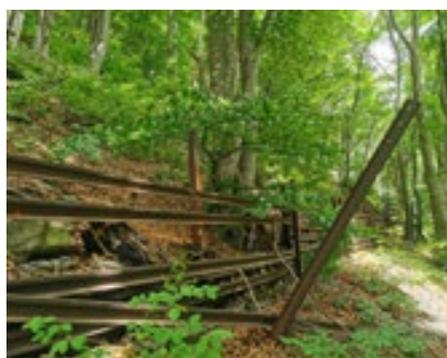
**Defekte Werke – Einige der über 130 Jahren alten Stahlwerke waren stark beschädigt. Auch hat sich aufgrund des nicht mehr notwendigen Unterhaltes sehr viel Laub, Humus, Steine und Holz hinter den Werken angesammelt.**
