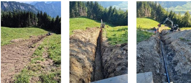
Die bestehende Quelleleitung sowie die Armaturen des Druckbrecherschachts waren stark sanierungsbedürftig. Über eine Länge von rund 125 Metern wurde die alte Wasserleitung von 80 mm durch ein neues PE 110 PN16-Rohrsystem ersetzt, das in einer Tiefe von 1,30 m verlegt wurde. Gleichzeitig wurden im Druckbrecherschacht alle Armaturen und Stahlrohre durch hochwertige Edelstahlsysteme ersetzt, um eine langfristig sichere und moderne Wasserversorgung zu gewährleisten.
