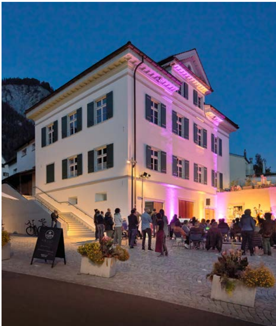
Malanser Schulhäuser müssen saniert werden
